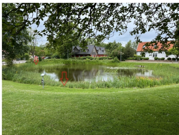
Figur 1 Placering af indløbsbygværk (forgrund) og udløbsbygværk (baggrund)
